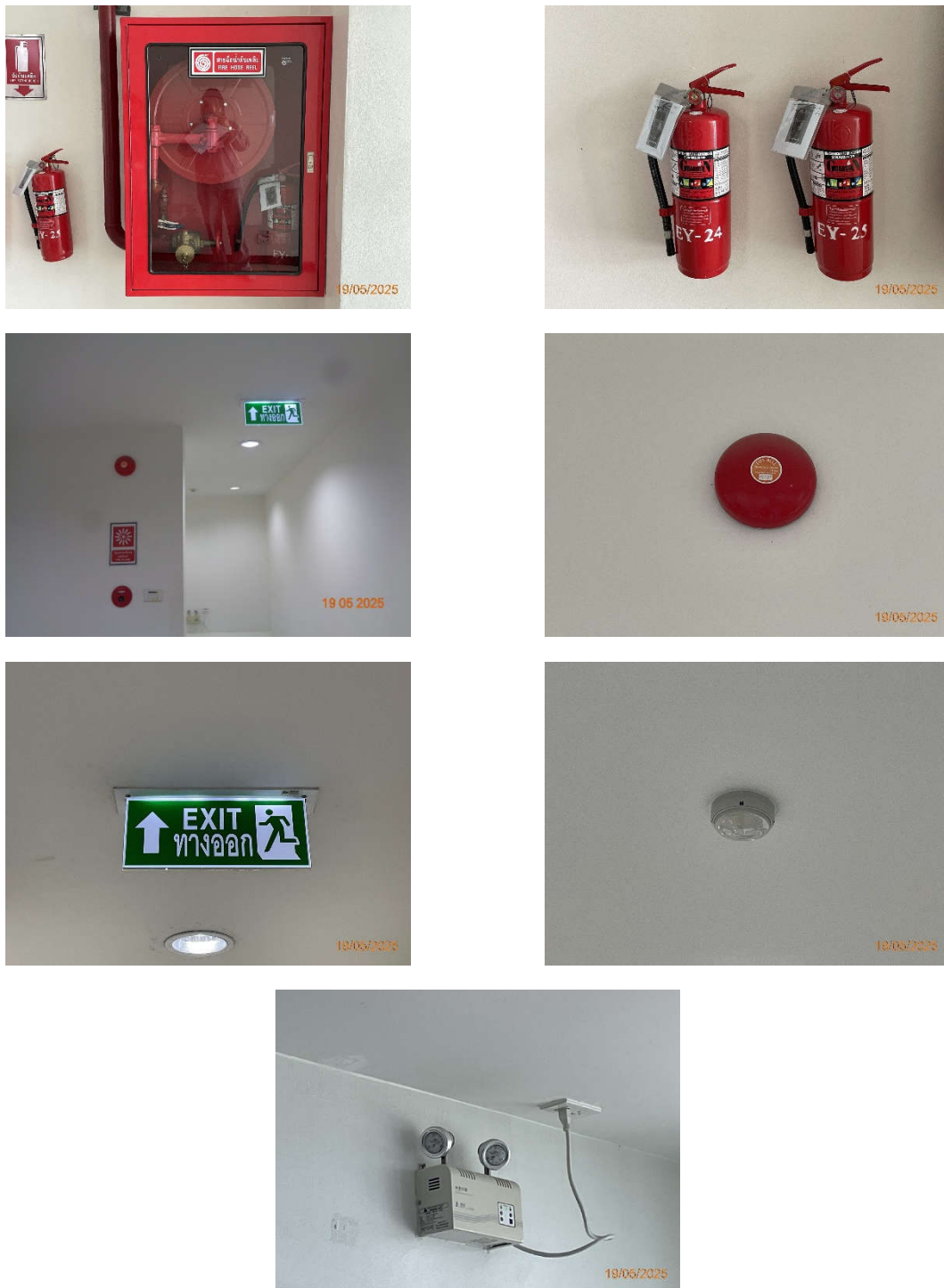
ภาพที่ 8 การติดตั้งสัญญาณเตือนภัย อุปกรณ์ดับเพลิง และไฟฉุกเฉิน
