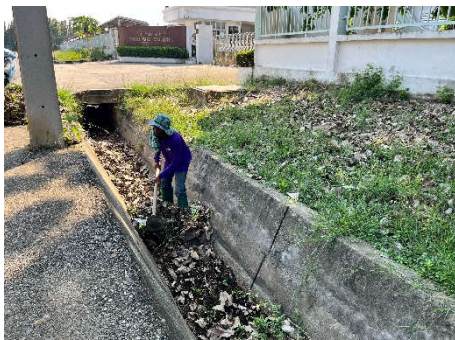
ภาพที่ 13 การขุดลอกตะกอนในรางระบายน้ำฝน
