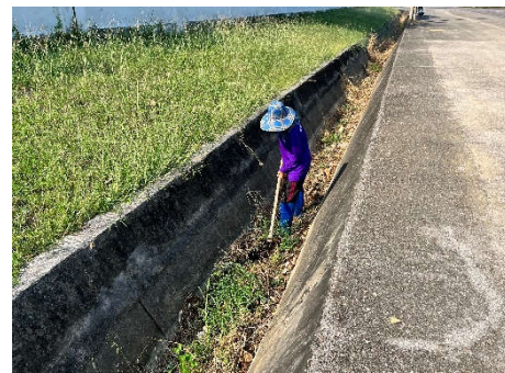
ภาพที่ 13 การขุดลอกตะกอนในรางระบายน้ำฝน
