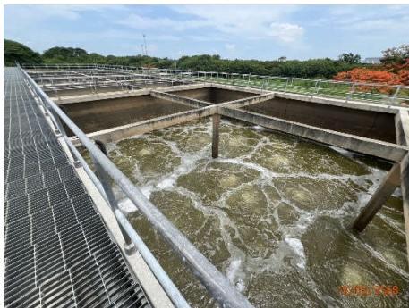
ภาพที่ 16 ระบบบำบัดน้ำเสียส่วนกลางทางชีวภาพ แบบ Activate Sludge
